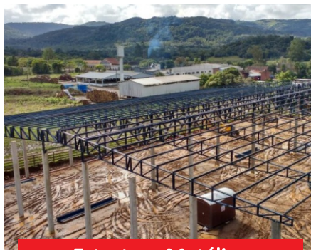
Estrutura Metálica 2350 m 2
