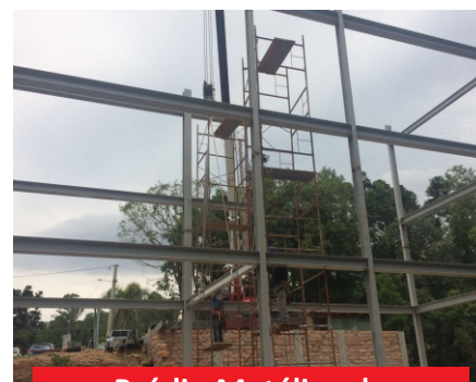
Prédio Metálico de 3 andares
