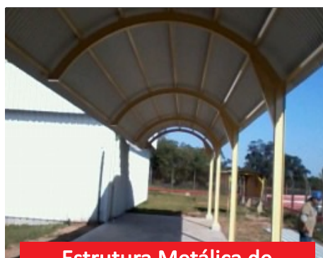
Estrutura Metálica de Passeio
