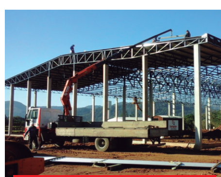
Troca de Telhas e Instalações
