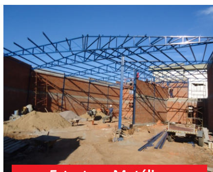
Estrutura Metálica 750 m 2
